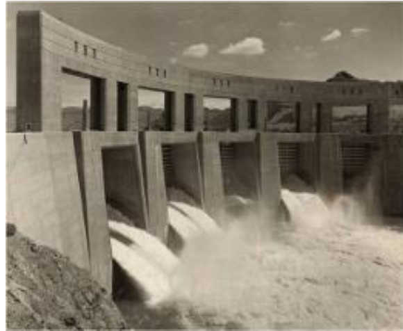
Wasserkraftwerke (z. B. Parker Dam)
