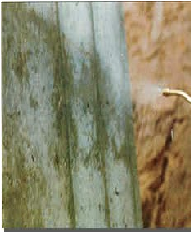
Aufbringen von Metasiel auf die Außenwand
